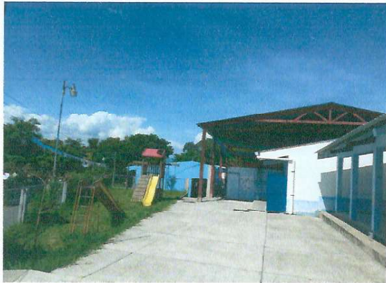
Foto1: Instalacion de estructura de techo tipo portico y cubierta de lamina calibre 26
