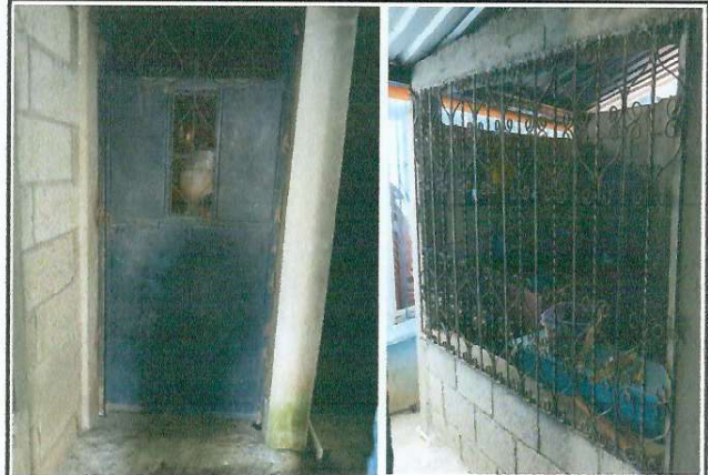
Foto 2: Mejoramiento de estructura de techo y cubierta de lamina en area de cocina, mejoramiento de puerta y balcones en area de cocina.
